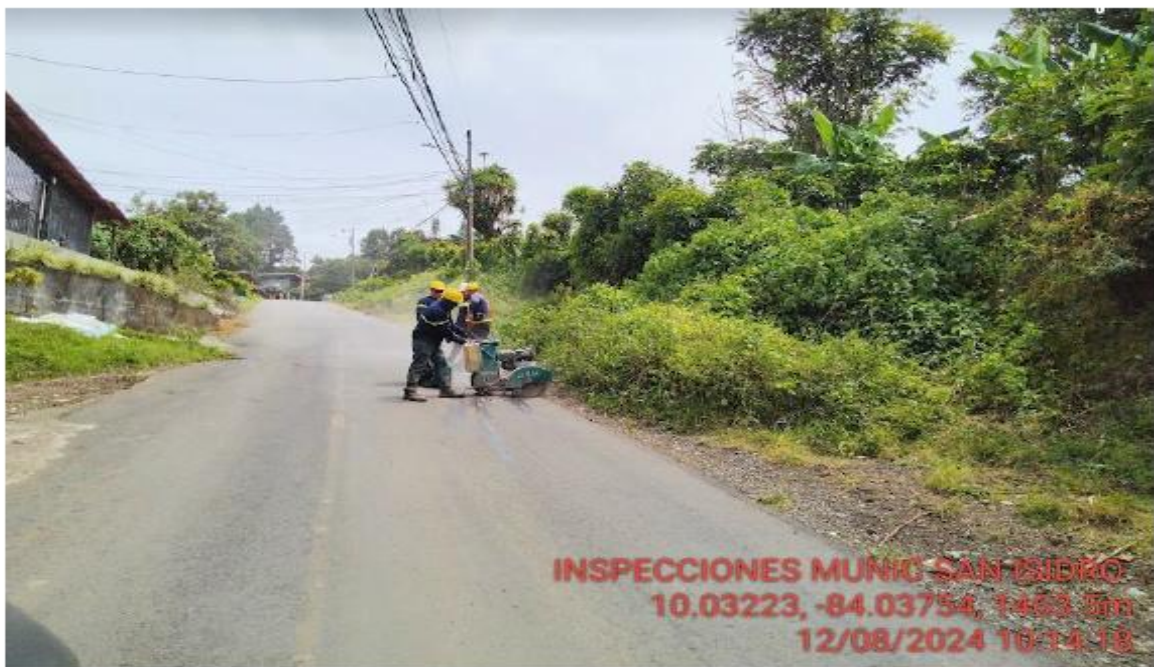
Anexo 2: Corte de la capa asfáltica.
