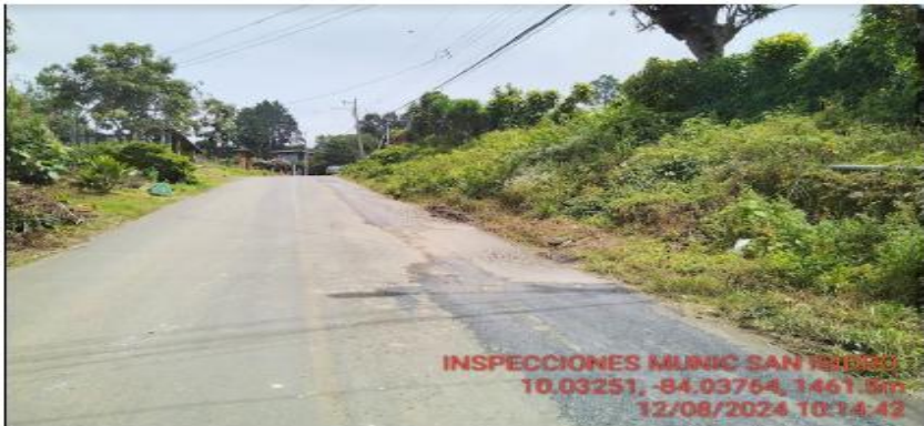
Anexo 3: Cortes en la capa asfáltica ya realizados, 12 de agosto del 2024.
