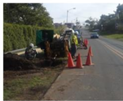
Instalación de 950 m de tubería para llevar el agua del Pozo Santa Cruz II hacia el Tanque San Isidro [¢ 84 millones]
