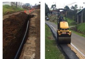
Instalación de 3 568 m de tubería nueva en San Isidro (Calle Chilillal, Calle Chávez, Calle la Rinconada y Calle el Astillero) [¢ 173 millones]
