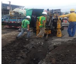
Instalación de 950 m de tubería para llevar el agua del Pozo Santa Cruz II hacia el Tanque San Isidro [¢ 84 millones]
