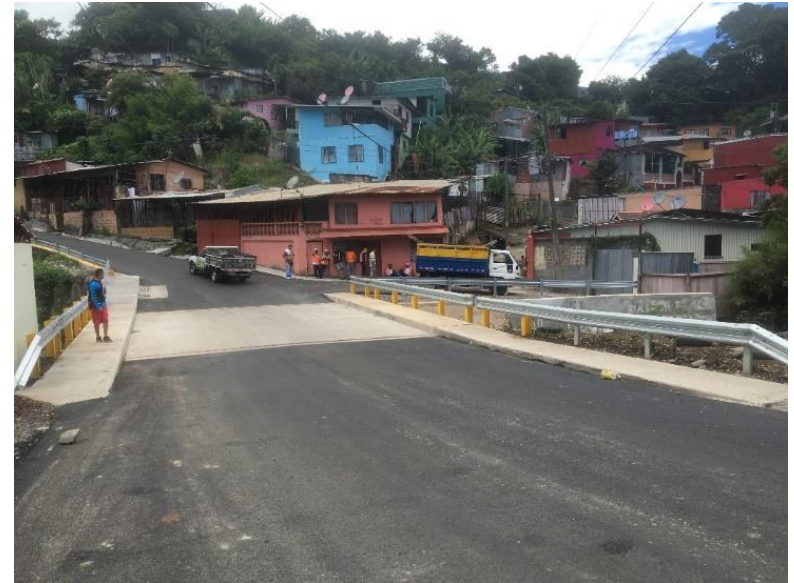
Después de la intervención
