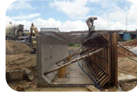
Colocación de concreto estructural y acero de refuerzo
