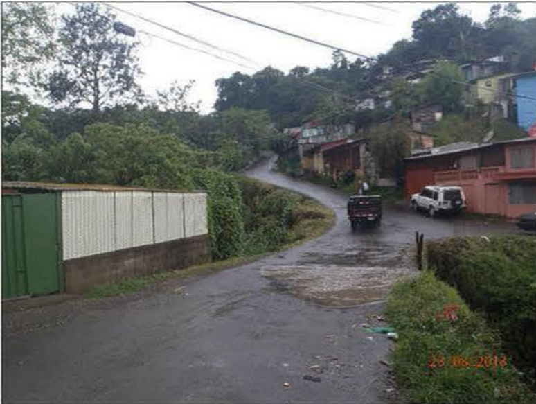
Antes de la intervención
