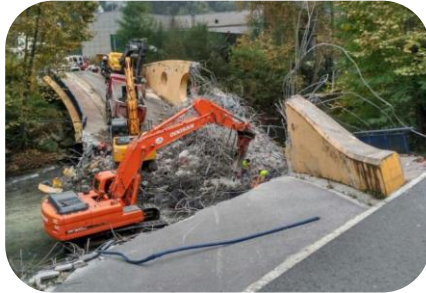
Remoción de estructura existente y excavación para estructuras
