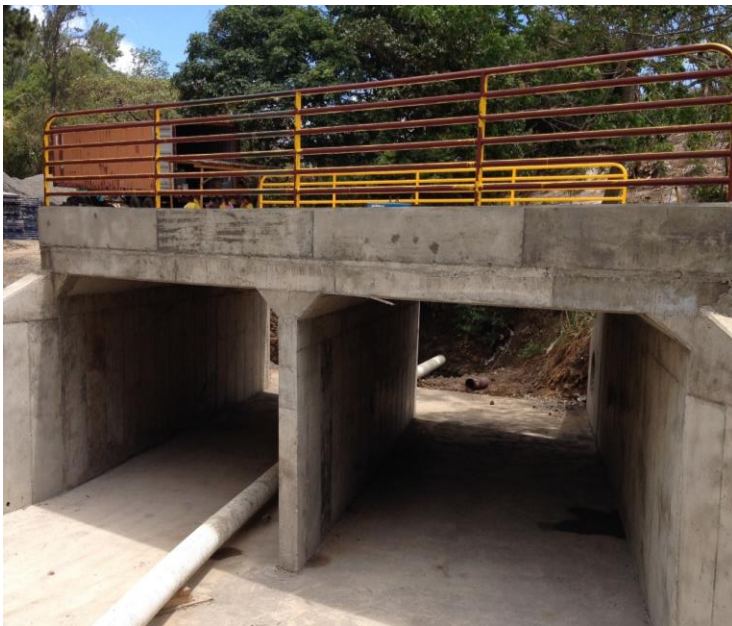
Durante la intervención
