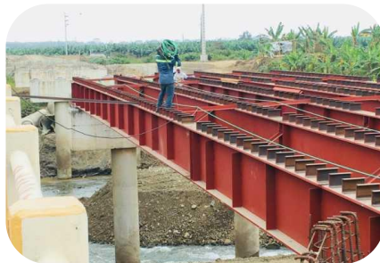
Colocación de vigas metálicas
