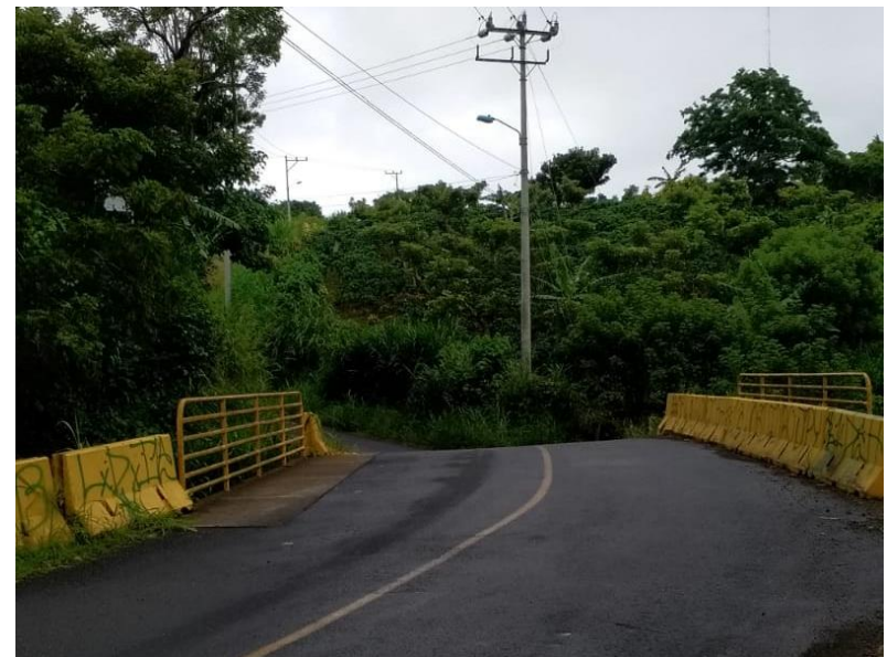
Después de la intervención
