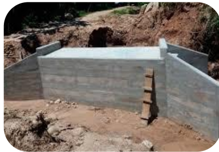
Construcción de accesos de aproximación
