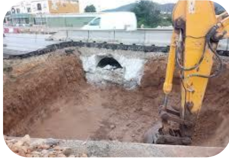
Excavación para obras mayores
